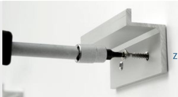
Der nicht vorgebohrte Abstandhalter (A) wird an der Unterseite des Schallsaugers angebracht.
