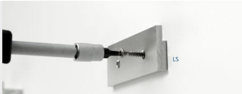
Der nicht vorgebohrte Abstandhalter (A) wird an der Unterseite des Schallsaugers angebracht.
